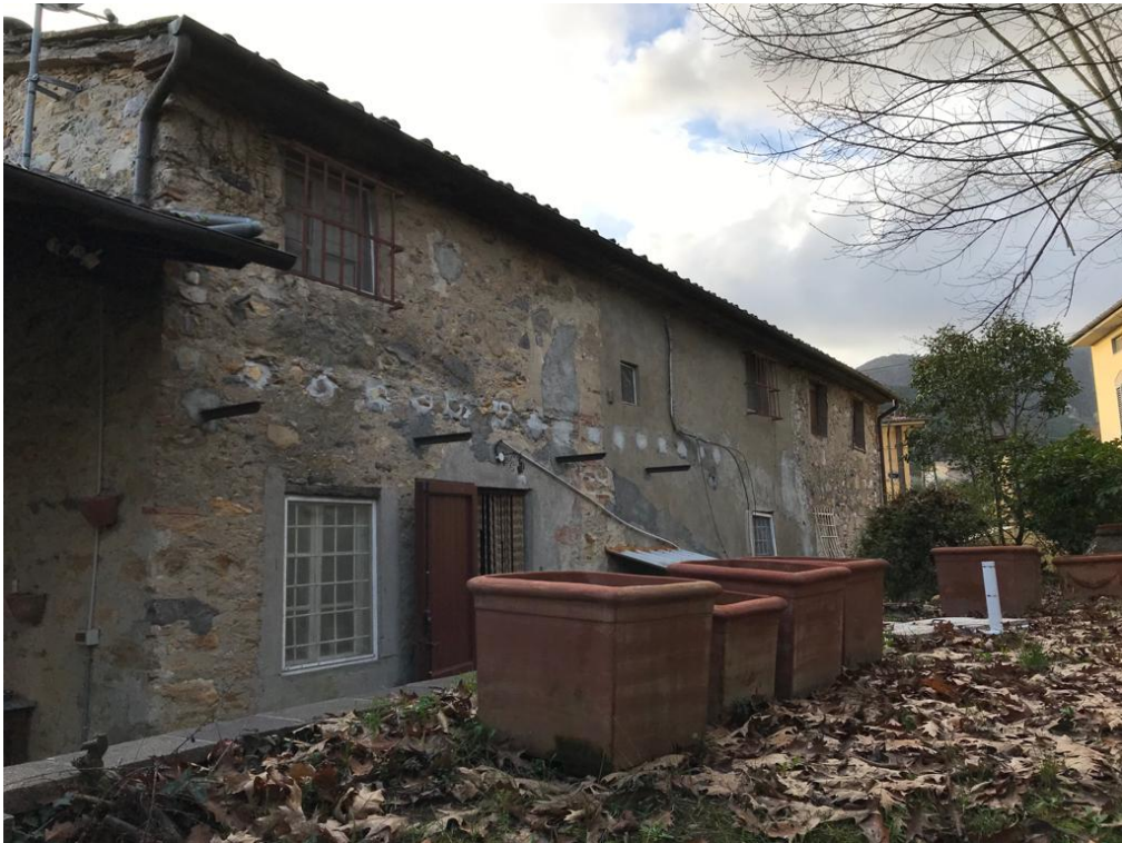
Foto n° 6 - vista lato ovest direzione sud
