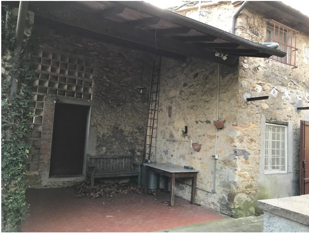
Foto n° 7 - particolare lato nord ovest
