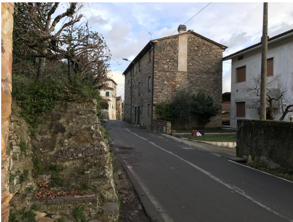
Foto n° 13 - Vista nord da Via Nuova
