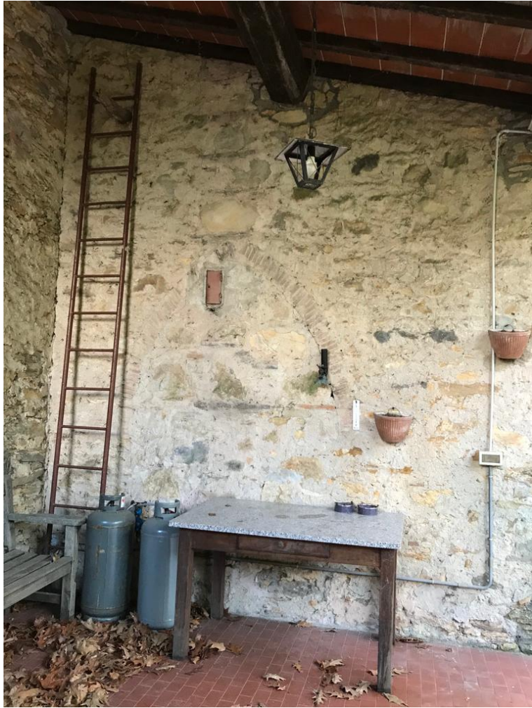
Foto n° 5 - particolare laterale apertura a sesto acuto "tamponata"
