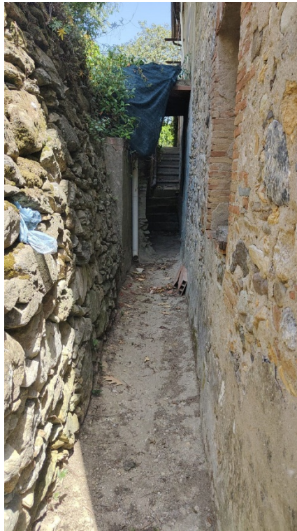
Foto n° 4 particolare scannafosso
